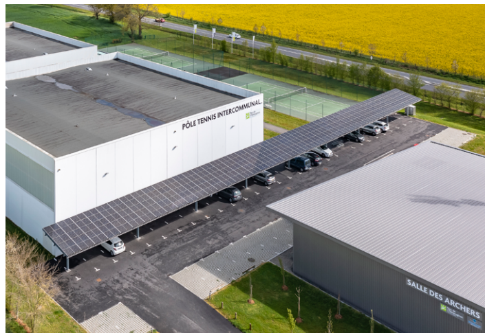
Ombrières de la salle des archers à Domloup - 390 m 2 en revente
