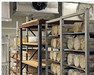
système de production de froid pour leurs 300 m<sup>2</sup> de caves d'affinage. Par un système utilisant de l'eau glycolée au lieu de gaz, l'entreprise espère passer d'une émission équivalente à 55,5 tonnes de CO<sub>2</sub> par an à 6,3 tonnes, soit presque 9 fois moins !
